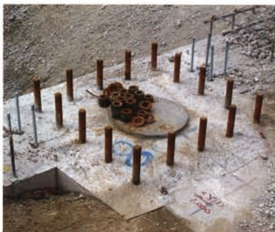
コンクリート打設・建て方埋め戻し
