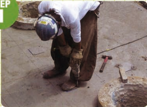
固定板取付作業
