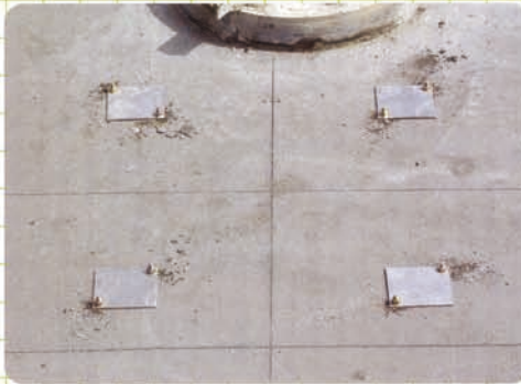
固定版取付完了
