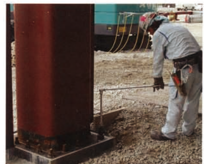
アンカーボルトへの張力導入作業
