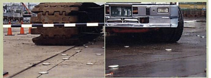
リンクプレートによる施工で、切り板溶接部の破断・端部の反り・鉄板のパタツキを解消します。
