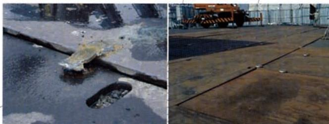
従来の切り板の溶接による連結はバタツキが生じます⇒リンクプレートにより平坦に連結可能
