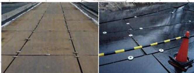
リンクプレートによるフラットな状態例
